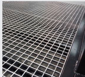
Suelo de la rampa tramex.
