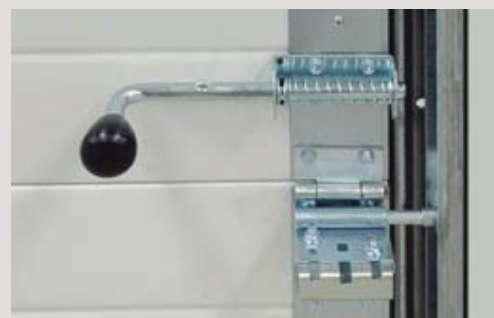
Cerrojo de seguridad que bloquea la puerta desde el interior.
